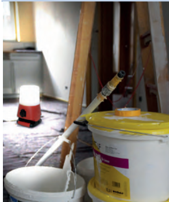
Renovierungsarbeiten 4000lm 360° Rundumlicht
