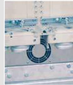
Doppelkabelverschluss mit Kabelschellen, 400V Schaltraum zwangsbelüftet
