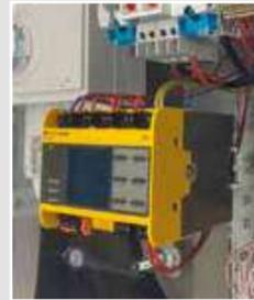
Isolationsüberwachung der 1.000V Strecke, Traforaum zwangsbelüftet
