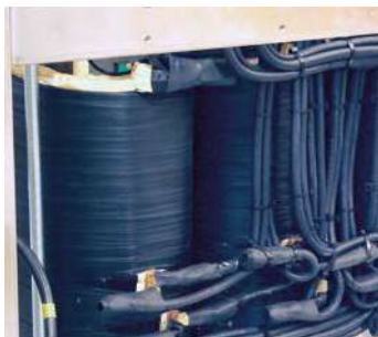
Hochwertiger Trenntransformator mit äußerst niedrigen Leerlaufverlusten unter 0,5%
