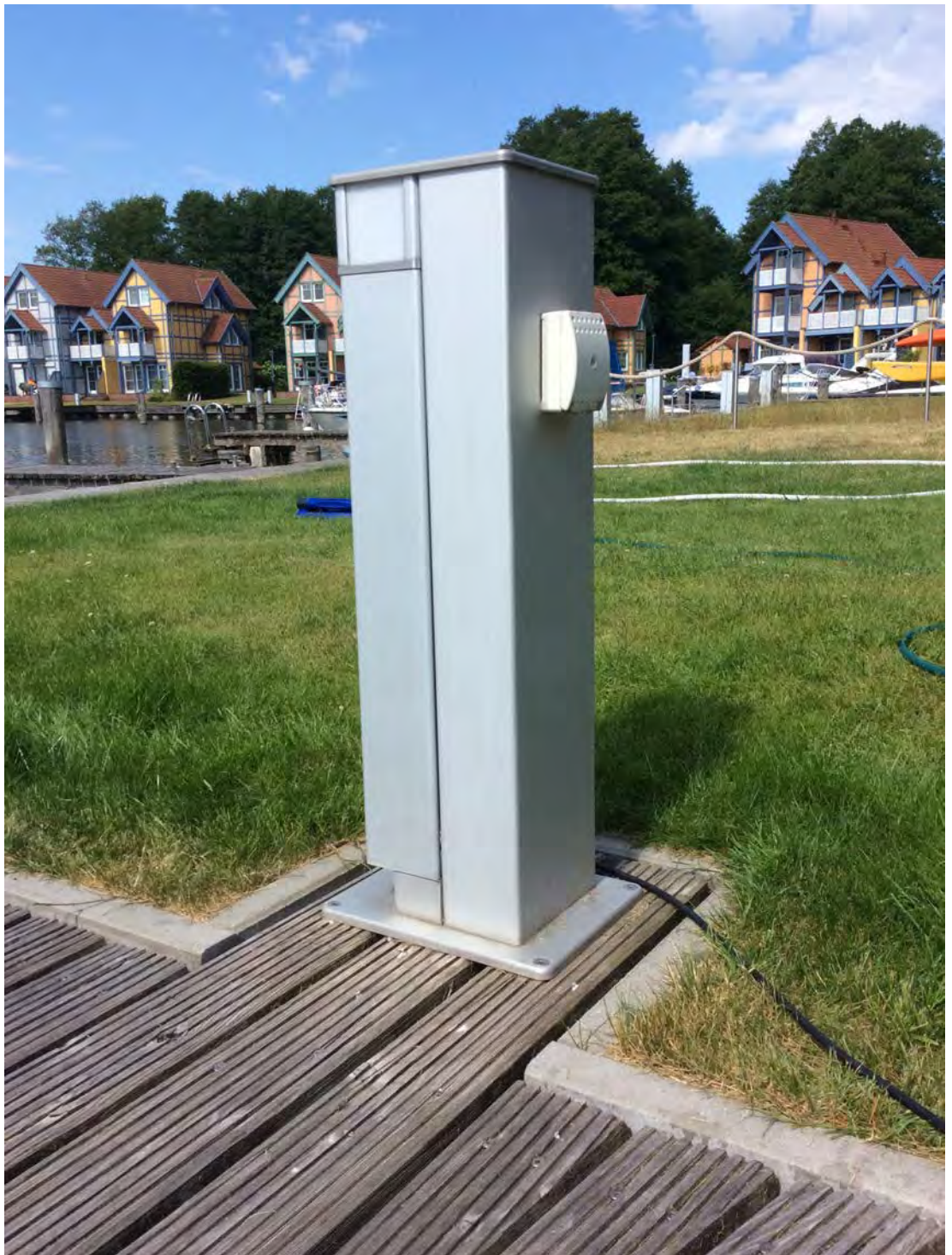
■ Abbildung zeigt Säule mit LED-Unterbauorientierungslicht, Höhe 1200mm
